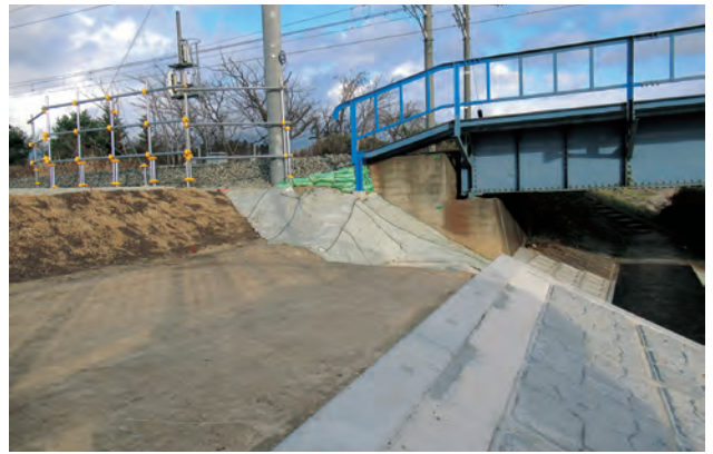
▲堤防の一部が周囲より低くなっている (写真は緊急復旧後)
