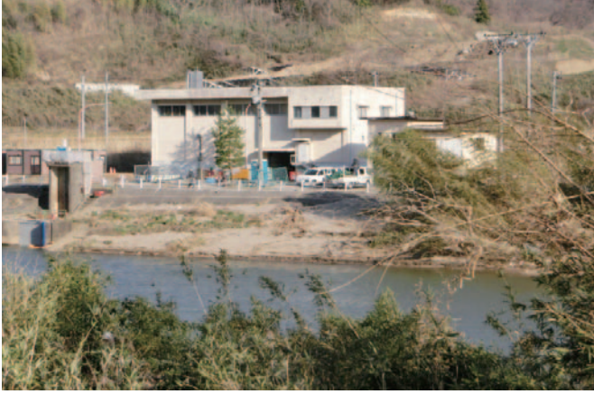
▲揚水場の早期復旧を
