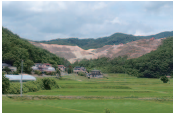
▲造成工事中のメガソーラー施設
