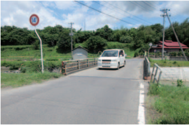
▲小幡橋の拡幅を行うべき
