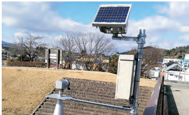
▲水害後設置された危機管理水位計
