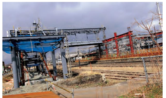
▲改修が進んでいる本宮駅
