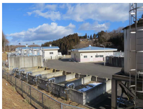
平田石浄水場
