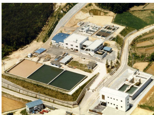
立石山浄水場
