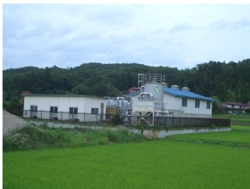
東禅寺浄水場
