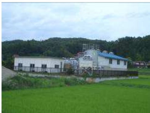
東禅寺浄水場
