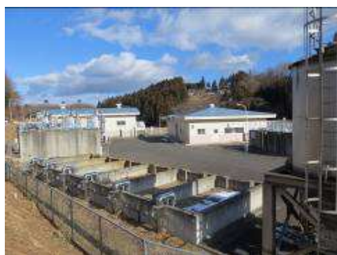
平田石浄水場
