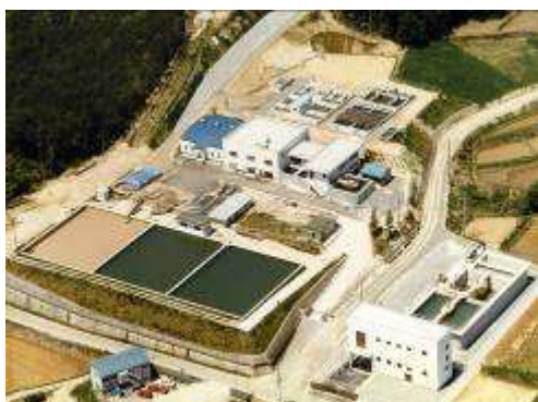
立石山浄水場
