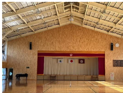
白岩小学校体育館 (令和4年復旧改修)
