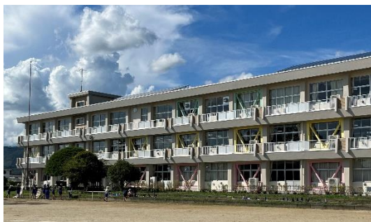
五百川小学校 (平成26年耐震補強)
