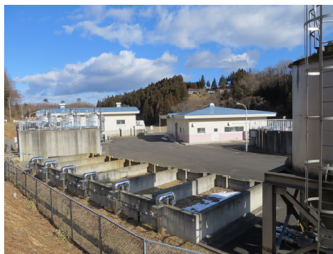
平田石浄水場
