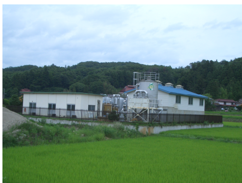
東禅寺浄水場
