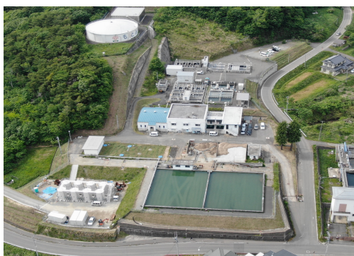
立石山浄水場
