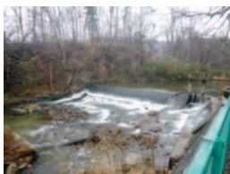
▲日影沢頭首工及び立石山浄水場の現地調査を実施
