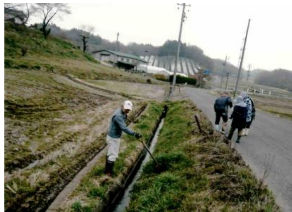
水路の泥上げ
