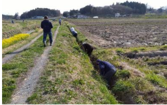
水路の泥上げ
