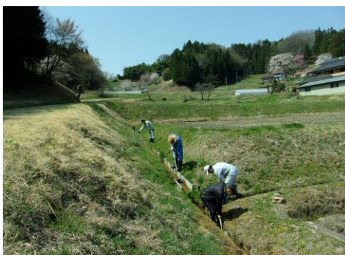
水路の泥上げ
