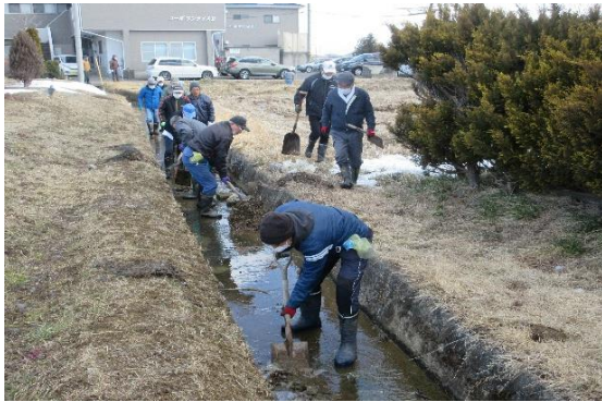
水路の泥上げ
