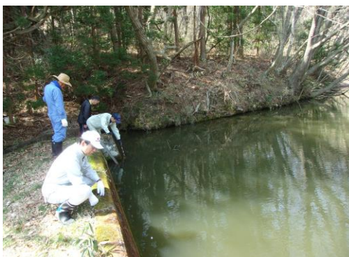
ため池の点検
