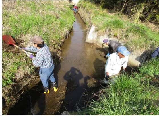
水路の泥上げ
