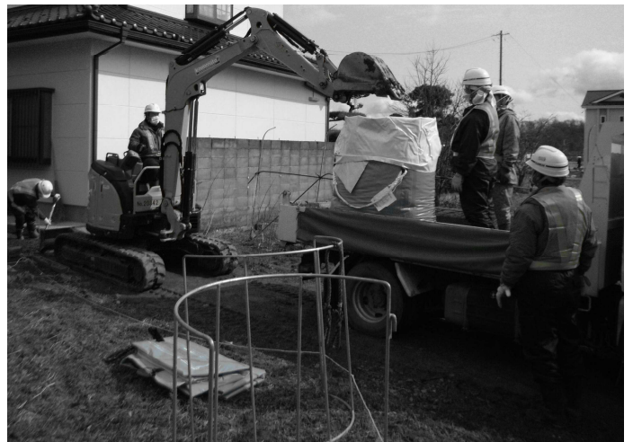
▲住宅除染の様子
