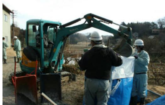
▲和田2区の住宅除染の様子。重機で表土を剥いで、フレコンバッグに詰め込んでいます
