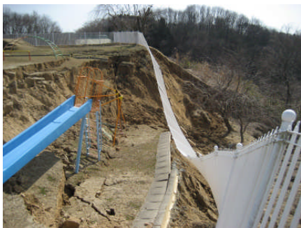
白沢保育所の法面
