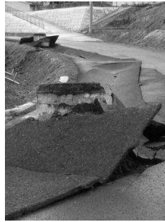
(上)本宮第二中学校の南校舎。 (下)青田地区の市道では下水道管のマンホールが隆起(写真右)したり、陥没した道路に車が巻き込まれた。
