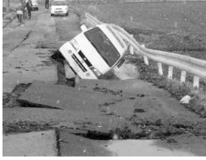
(上)本宮第二中学校の南校舎。 (下)青田地区の市道では下水道管のマンホールが隆起(写真右)したり、陥没した道路に車が巻き込まれた。
