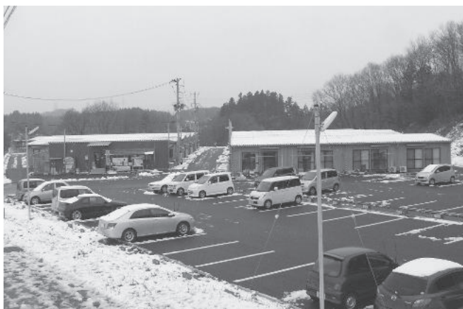
復興住宅の建設を（石神第1応急仮設住宅）
