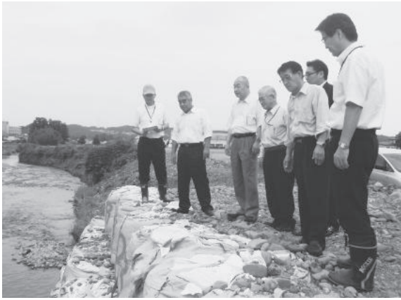
▲現地調査 「本宮字瀬樋内地内安達太良川堰被害状況」
