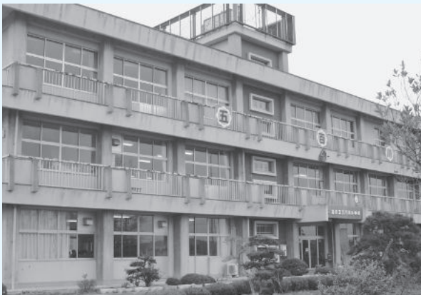
▲耐震補強工事を行う五百川小学校
