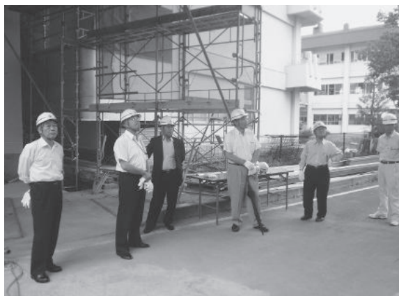
▲現地調査 「本宮第一中学校連絡通路」
