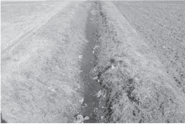
早期除染が望まれる農業用排水路
