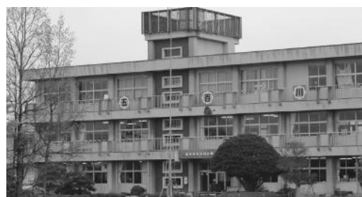
耐震化工事を行う五百川小学校
