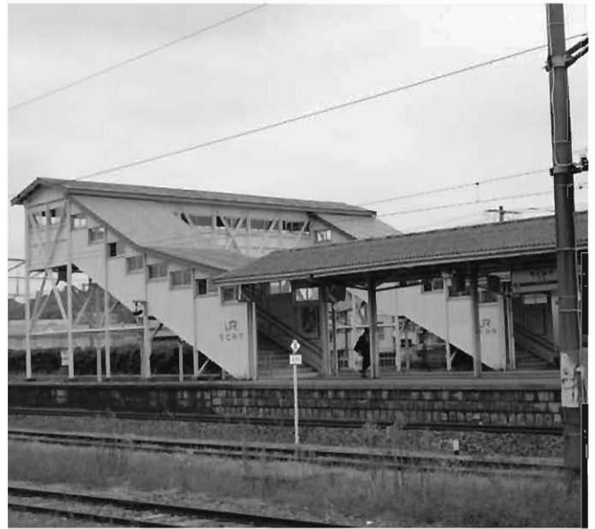
西側から見た本宮駅構内の跨線橋
