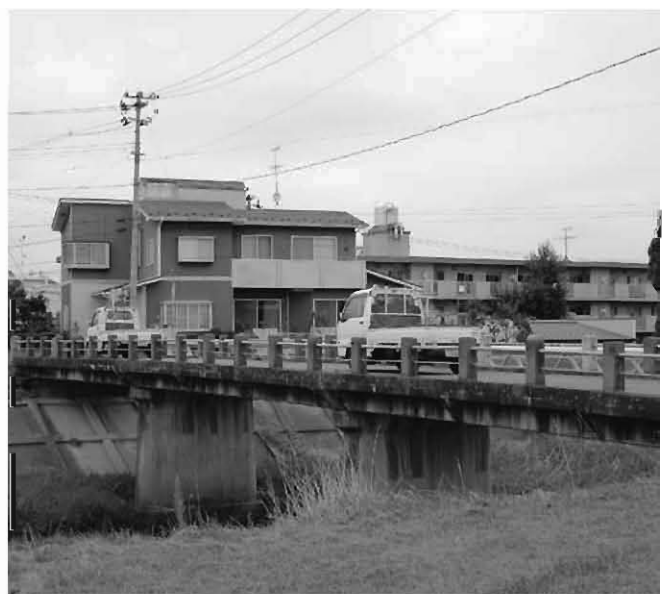
老朽化の安全対策は（昭和29年架橋の千代田橋）
