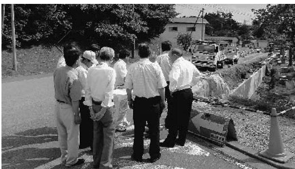
現地調査（市道 堤崎・平田石線）
