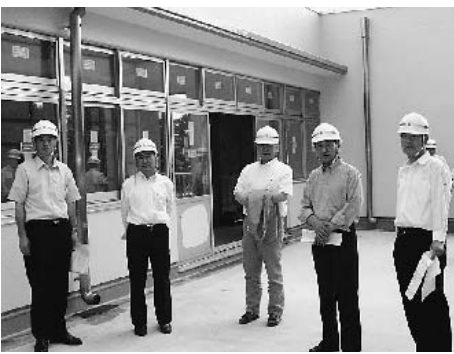
現地調査（本宮小学校第1校舎建設現場）
