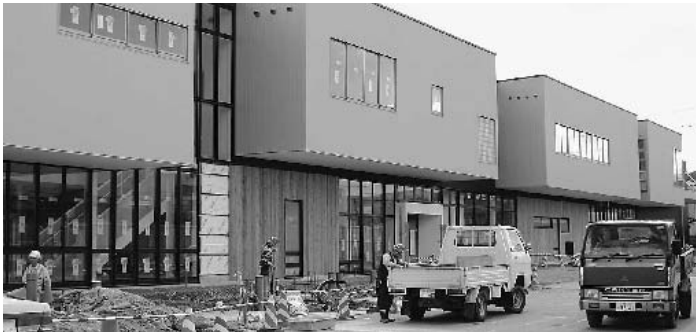
10月オープンに向け工事が進む市民元気いきいきプラザ
