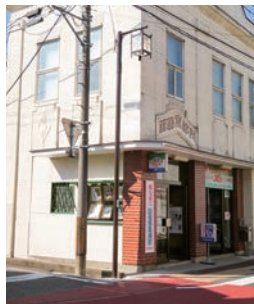
▲新しく設置されたLED型防犯灯
