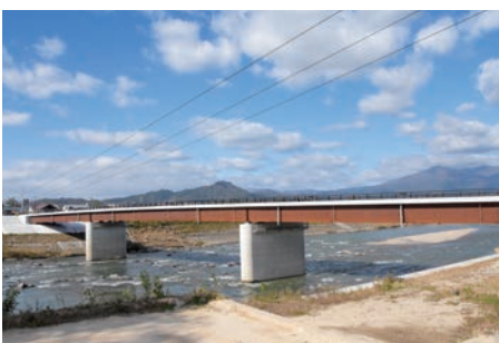
▲開通した新上ノ橋（全景）
