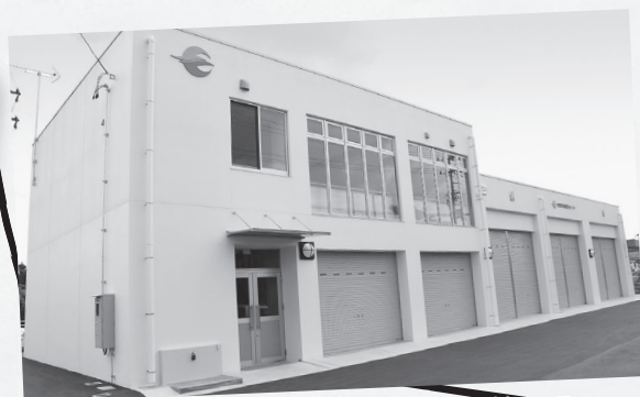
防災減災の拠点として整備された地域防災センター
