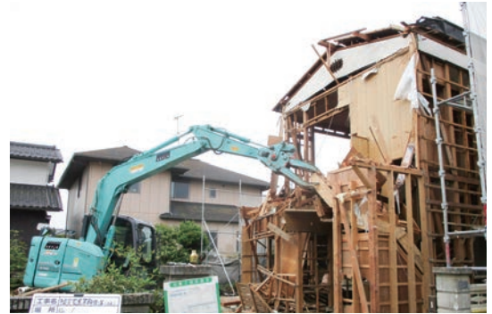
▲市で解体工事を行います
