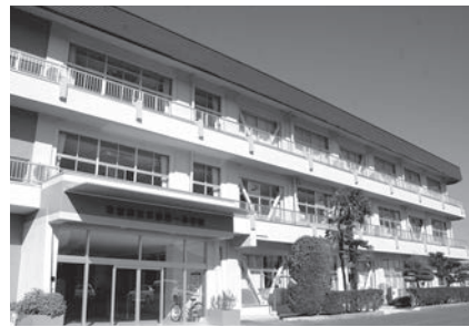
▲耐震補強改修工事が完了した本宮第一中学校の南校舎
