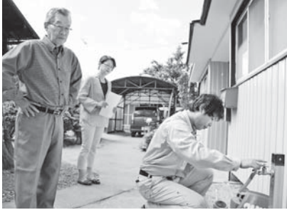
水道の点検を行う水道工事指定店会企業の職員（右）
