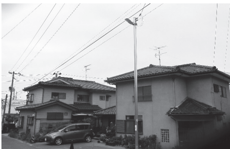
新しく設置されたLED型防犯灯
