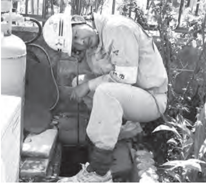
▶水道無料点検の様子
