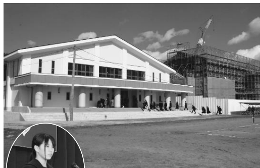
(上) 完成した本宮第二中学校の体育館とその東側で新築復旧工事が進む校舎の様子 (下) 生徒代表であいさつする遠藤瑠菜さん
