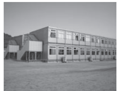
▲昨年7月に完成した仮設校舎
