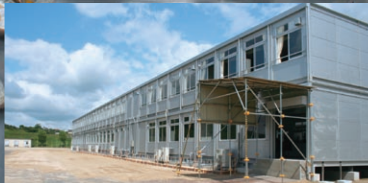
本宮第二中学校の仮設校舎。 プレハブ2階建2棟で、普通教室は10教室あります。
