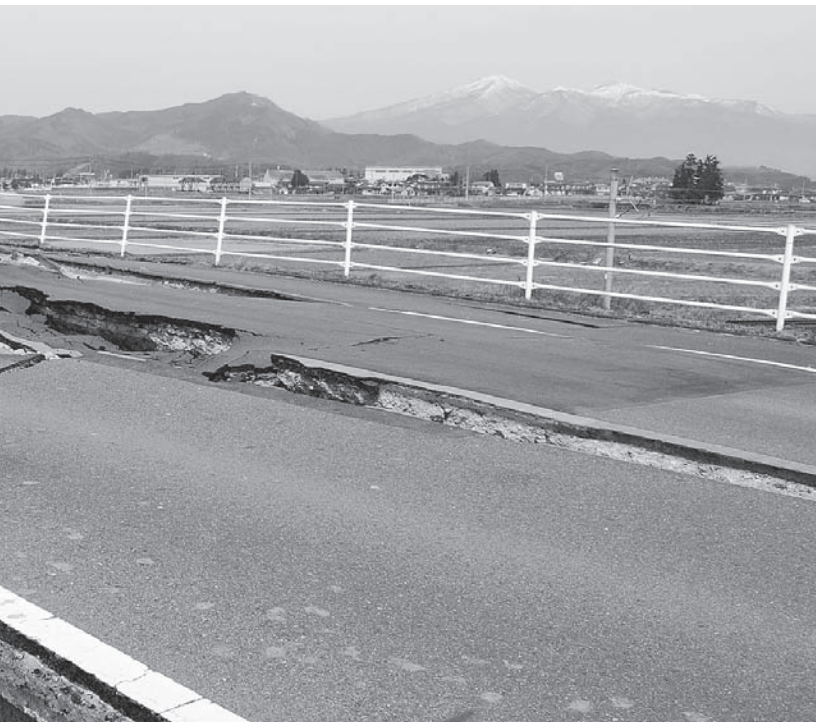
荒井字北ノ内地内のJR東北本線の跨線橋の前後の道路は、強い揺れで路面が完全に崩壊
