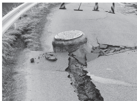
荒井字北ノ内地内のJR東北本線の跨線橋の前後の道路は、強い揺れで路面が完全に崩壊
