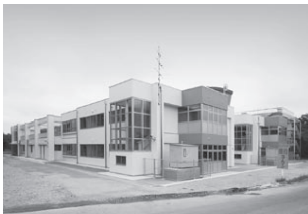
▲建物の北西面
