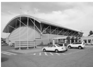
▲本宮第一中学校の体育館 (旧本宮体育館)
