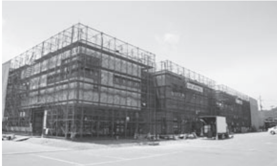
▲(仮称)複合施設(本宮字千代田地内)
