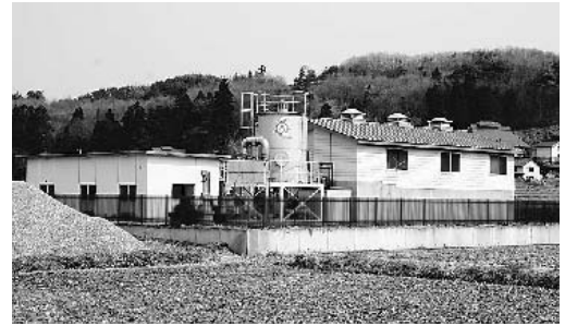
東禅寺浄水場までの水道管設置工事が始まる
