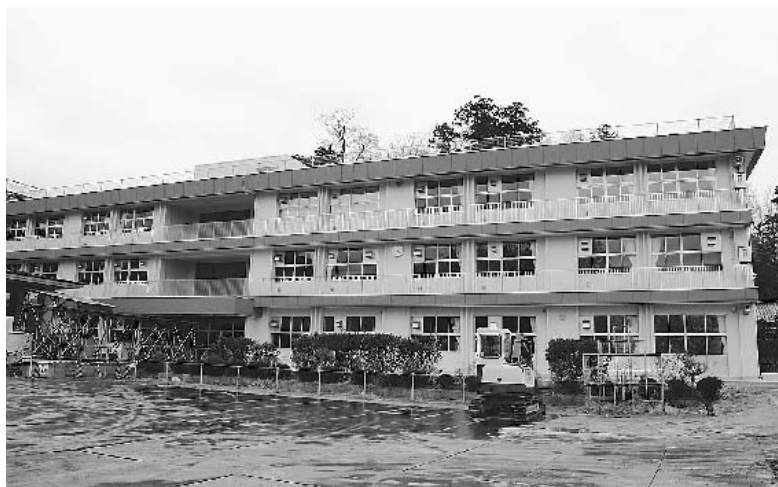
改修が終了した、本宮小学校第二校舎
